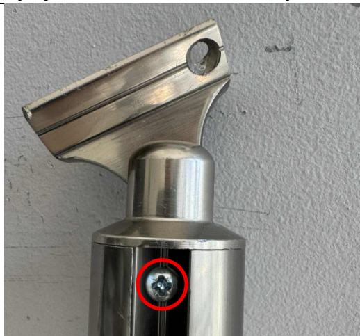
Spoj držáku madla ke sloupku zábradlí
